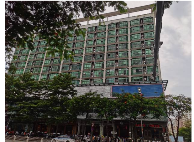
项目所在建筑西侧民泰大厦
