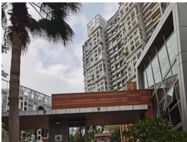
项目西南面泰华金逸世家 附图 3：项目四至和现状情况照片
