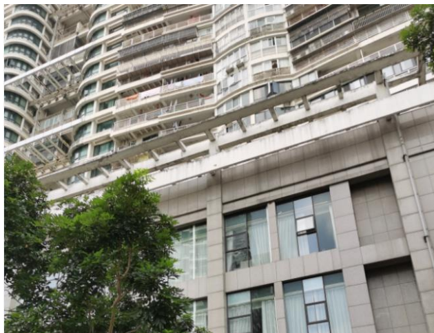
项目东北面金成时代家园 2 栋
