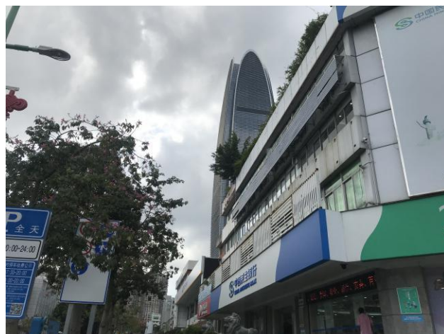
项目西南面博盛时代广场
