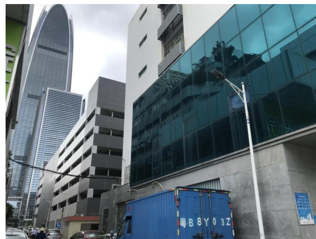
项目西北面商业楼
