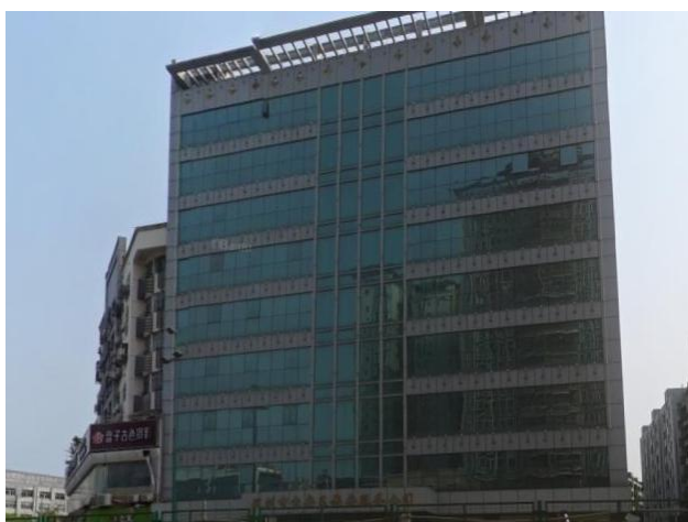
项目西南面保安大厦 附图 3: 项目四至和现状情况照片
